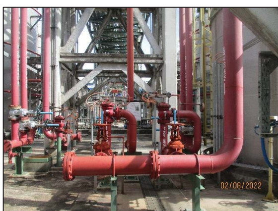
รูปที่ 3.41 Hydrant with Monitor
