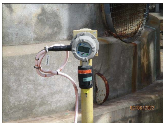
รูปที่ 3.51 Ammonia Gas Detector
