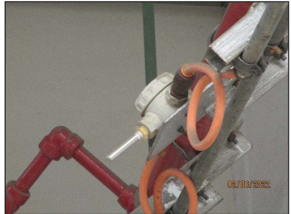
รูปที่ 3.32 Heat Detector
