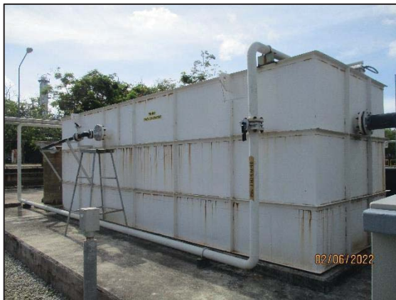
รูปที่ 3.15 Oil-water Separator (CPI)
