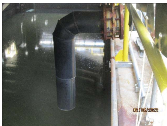
รูปที่ 3.17 Emergency Wastewater Basin (ภาพขณะอยู่ระหว่างการใช้งานในกรณีฉุกเฉิน ซึ่งสามารถ รับน้ำทิ้งได้อย่างเพียงพอ ทั้งนี้โครงการมีการควบคุมดูแล บ่อบำบัดน้ำทิ้งฉุกเฉิน ให้มีสภาพพร้อมใช้งาน และให้อยู่ระดับต่ำหรือแห้งอยู่เสมอ)
