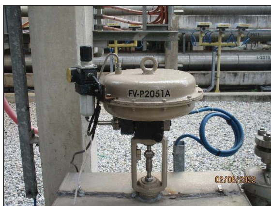
รูปที่ 3.56 Pressure Flow Control Valve
