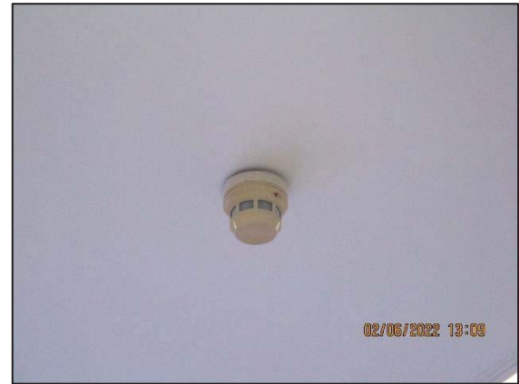
รูปที่ 3.34 Smoke Detector
