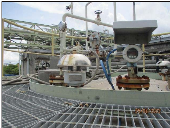
รูปที่ 3.47 Pressure Safety Valve
