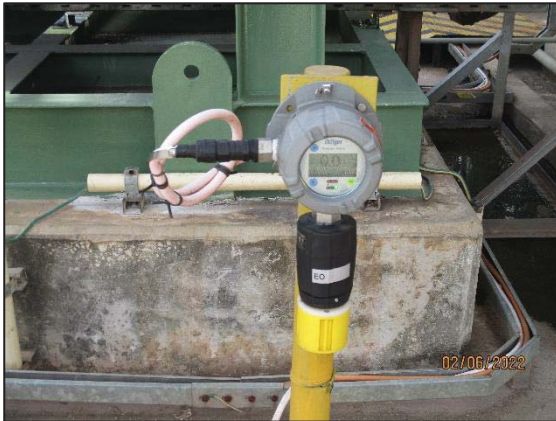
รูปที่ 3.31 EO Analyzer
