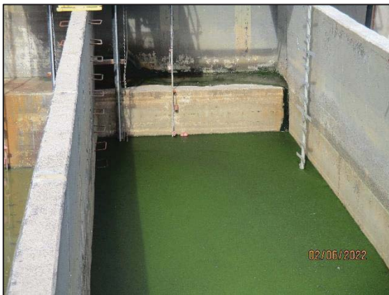
รูปที่ 3.3 บ่อ Neutralization (TK 201)
